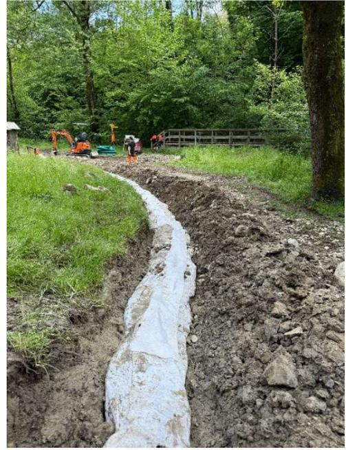
Dopo aver posato il pozzetto abbiamo posato la stuoia geotessile e riempito con un primo strato di ghiaione di 5-10 cm.
