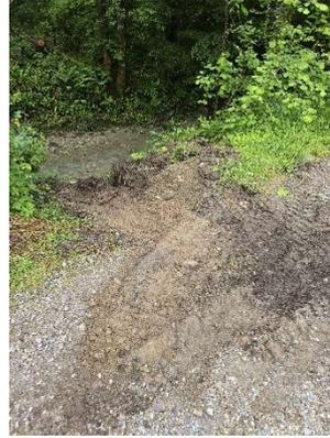
Per proteggere la strada dall'erosione e dal deterioramento causato dall'acqua, sono state create cinque canalette
