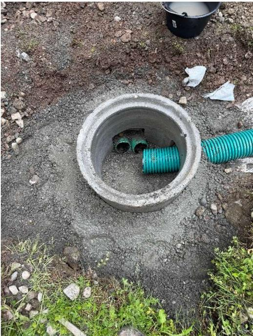
Dopo aver finito lo scavo abbiamo posato un pozzetto in cemento 50x50 che farà da collegamento tra il tubo di drenaggio vecchio e quello nuovo. Abbiamo dovuto tagliare il tubo di cemento per fare gli accessi dei tubi di drenaggio.
