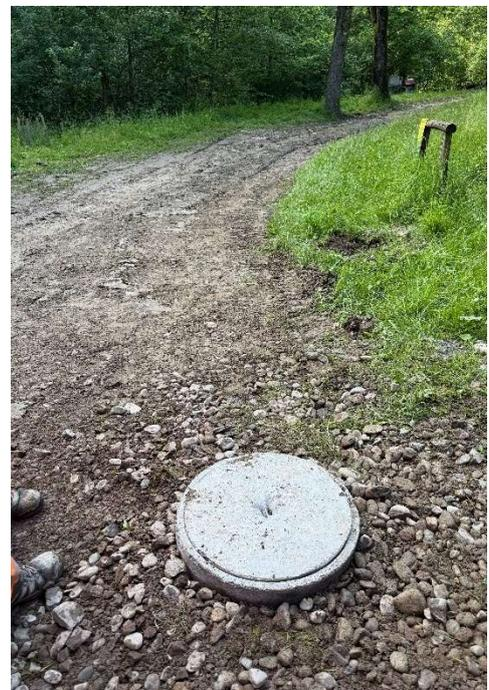
Infine, abbiamo ricoperto lo scavo, sistemato la plania della strada e cilindrato.
