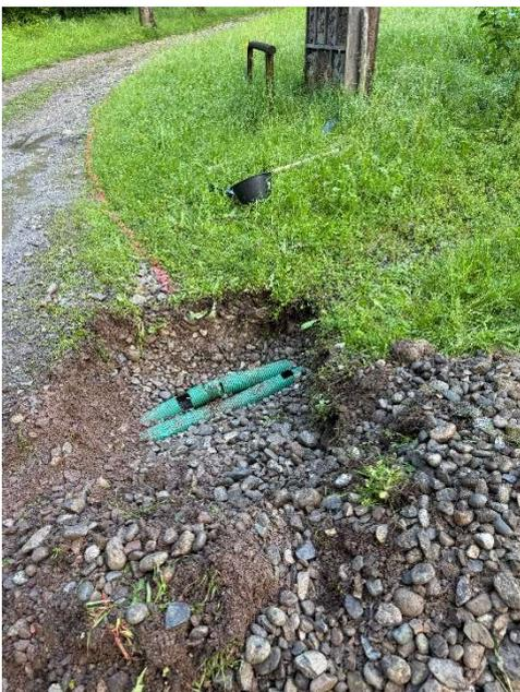
Come primo lavoro abbiamo eseguito un sondaggio alla fine della discesa per cercare il tubo di drenaggio già esistente al quale dovremo poi collegarci con il nuovo tubo.
