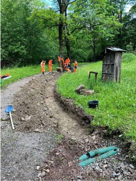
Una volta trovato il tubo esistente abbiamo eseguito uno scavo 45x60 lungo il bordo della strada per una lunghezza di 30 m.
