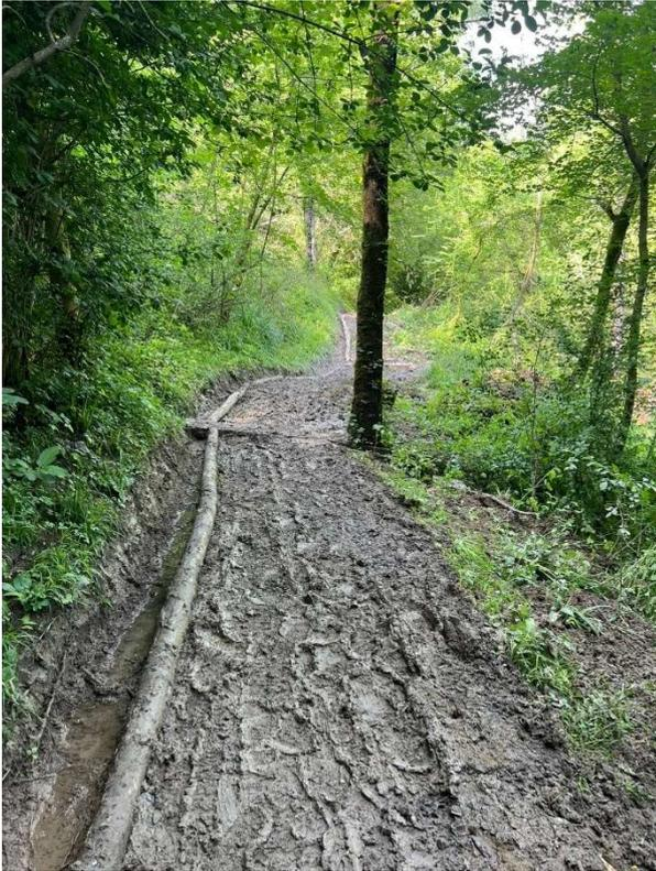
In questo punto si può notare il materiale scavato, i tondoni spostati e la guscia della canaletta scavata e pulita e si vede già l'acqua dentro che sta facendo il suo lavoro.
