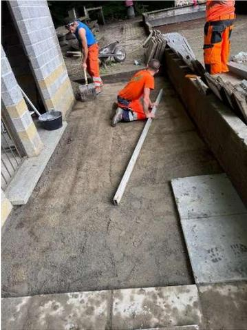
successivamente abbiamo finito di fare la plania appunto con sabbia e cemento non bagnata ma a secco, il piano è stato fatto con delle fasce per staggiare e una stadia.
